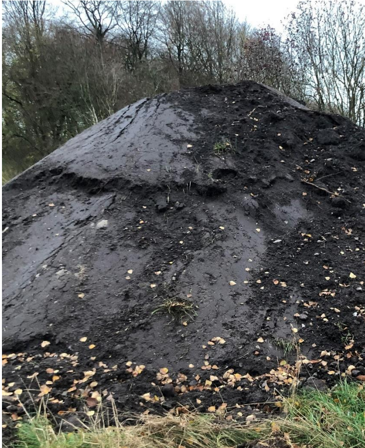
Afrømmet jord med højt indhold af organisk stof ifm. byggemodning af området syd for Kallund Mose.
